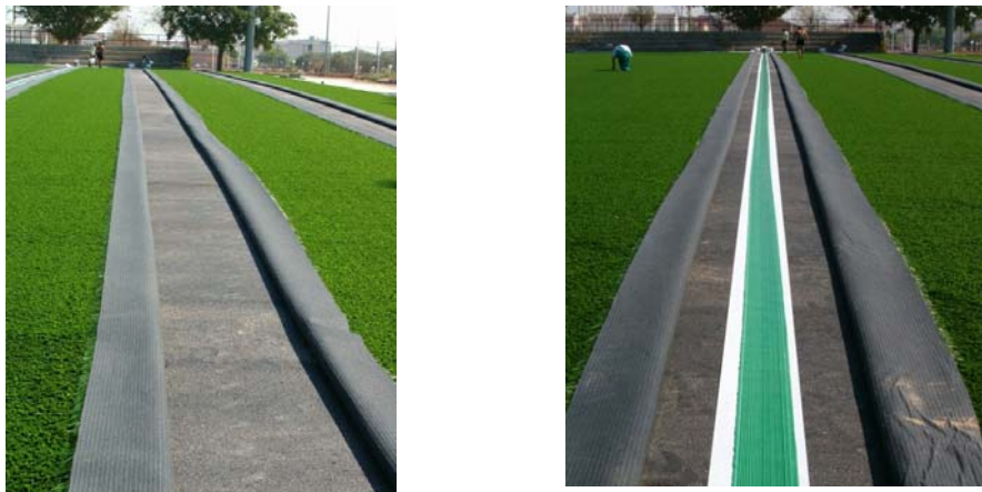
Ajuste de los laterales de los rollos de césped artificial.
