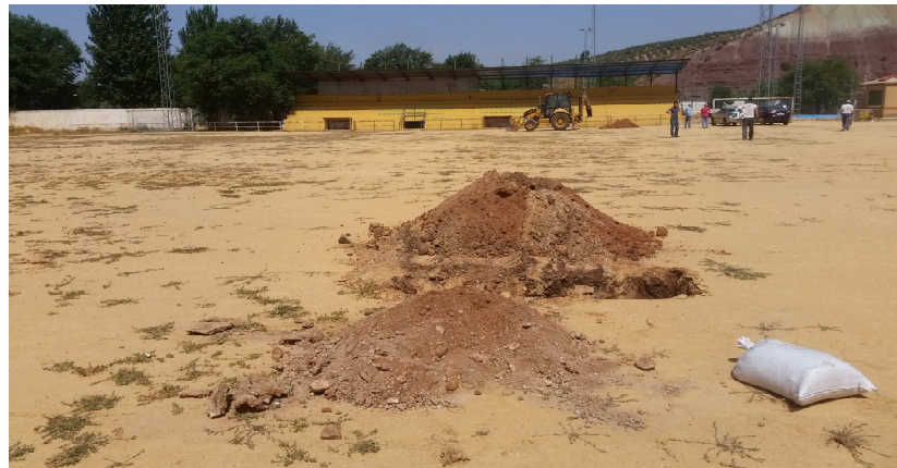
Figura Nº 2.- Ejecución de calicatas, donde se aprecia la C-01. en primer término, y la C-02 junto a la retroexcavadora.
